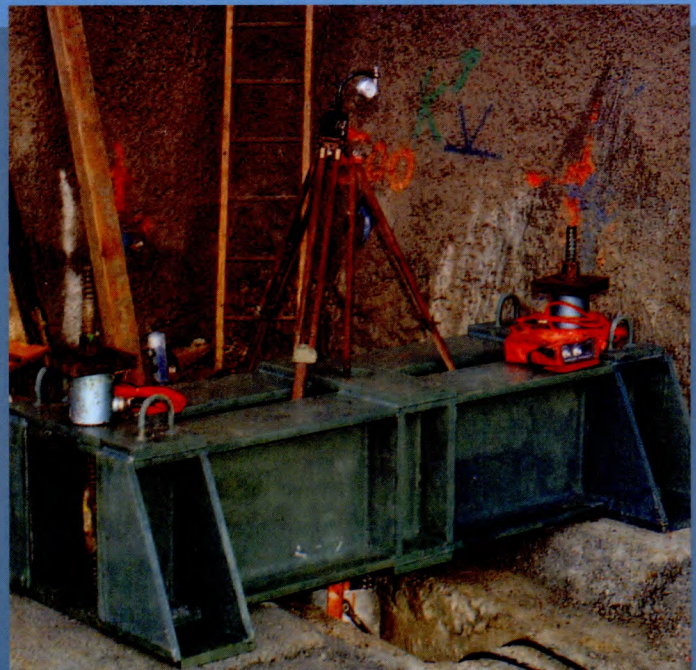
Prova de carga em canteiro de obra
