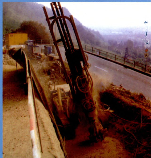
Fundações para paredes
