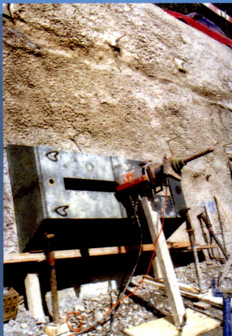
Prova de tração em canteiro de obra
