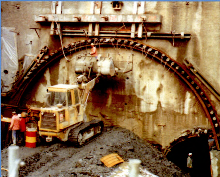
Enfilagem tubular injetada
