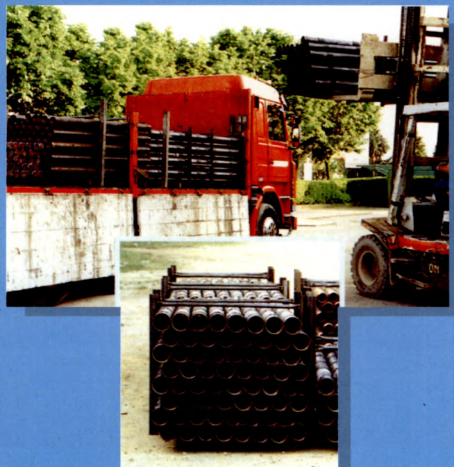
Abastecimento da obra
