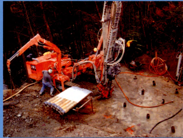
Microestacas para as fundações do encontro de uma ponte.
